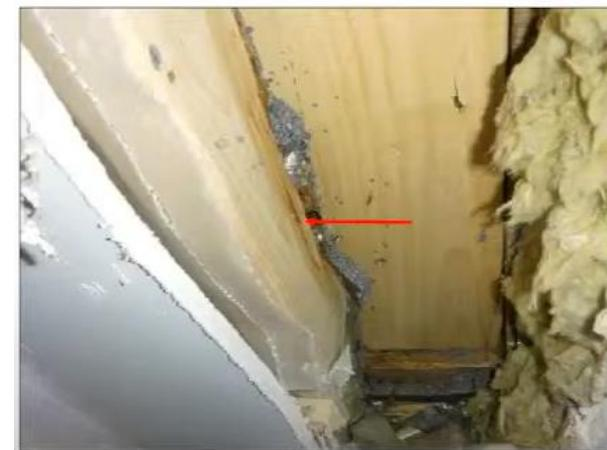
Photo 7 : Traces de condensation sur montant en bois. Cavité du mur limitée par deux pare-vapeur (salle de bain, 2<sup>e</sup> étage)
