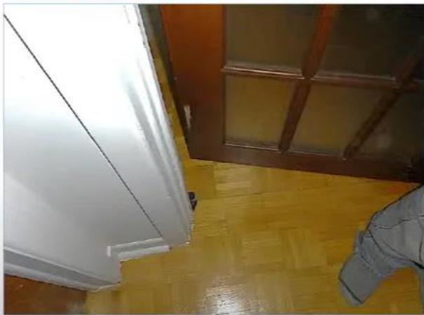
Photo 4 : Portes ne s'ouvrent pas. Elles frottent sur plancher ayant dénivellations importantes (2<sup>e</sup> étage)
