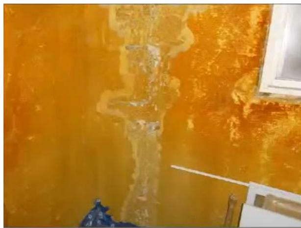
Photo 12 : Fissure et déplacement latéral dans mur de fondations. Indice d'un mouvement important dans ce mur (sous-sol)
