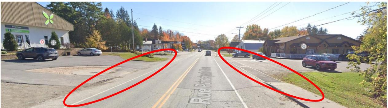
Figure 4.9 : Entrées de Proximed sans séparation physique ou visuelle et du Restaurant La Maison du Verger, dont le trottoir est remplacé par une zone délimitée par des lignes peinturées (CRE Estrie, 2022)
