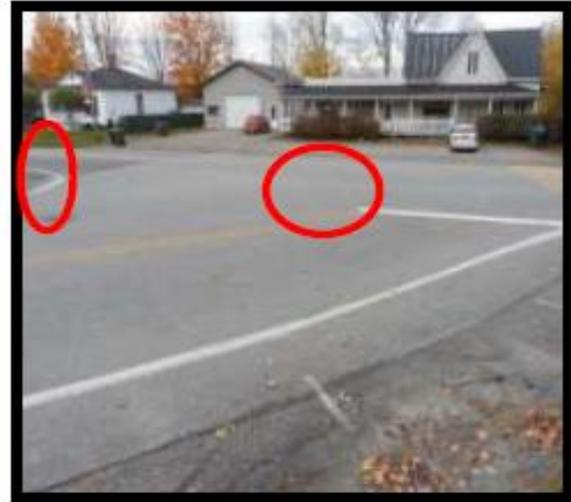
Figure 4.13 : Traces de pneus visibles sur la chaussée, témoins de manœuvres inadéquates à l'intersection (CRE Estrie, 2013)
