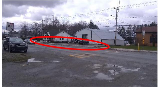
Figure 4.10 : Entrée Léo Agricole inc., trottoir abaissé au niveau de la chaussée (CRE Estrie, 2022)
