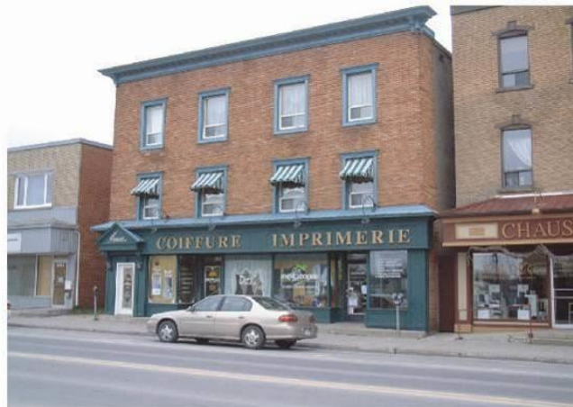
LA RELATION ENTRE LES OUVERTURES ET LES MURS PLEINS DEVRAIT ÊTRE SEMBLABLE À CELLE DES BÂTIMENTS EXISTANTS DANS LE VOISINAGE.
